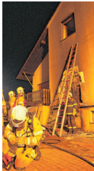
Gefährlich: Die Dämmung in der Hauswand hatte auch Feuer gefangen. FOTO: FEUERWEHR
